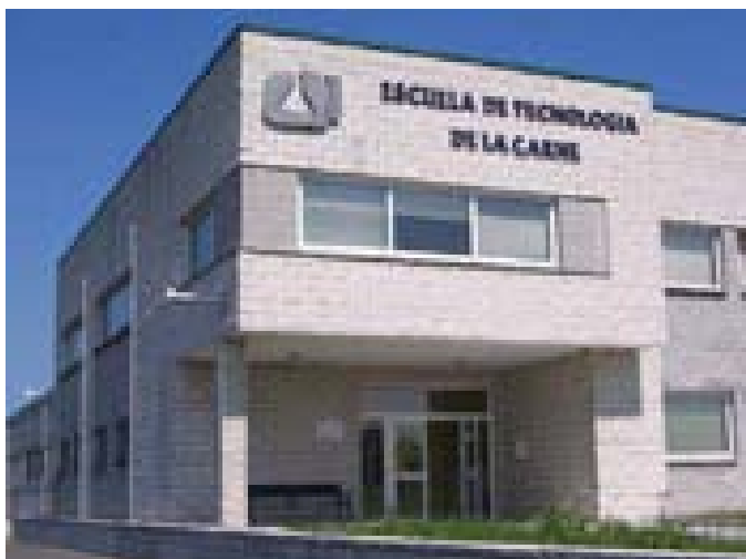
Instalaciones de ASINCAR
