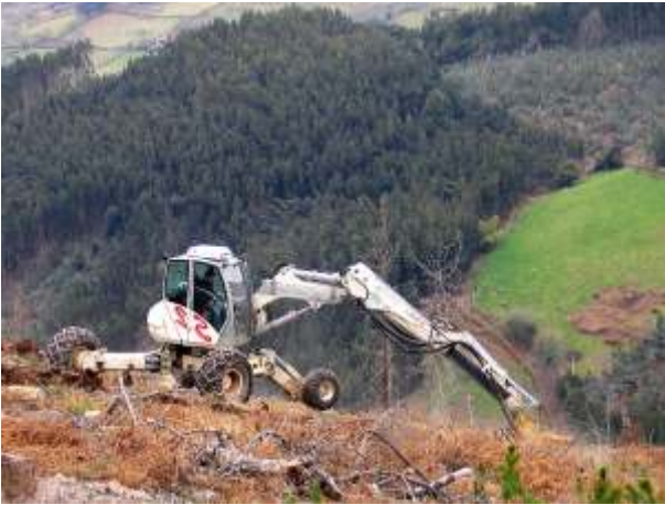
Retroarañas realizando desbroce por hoyos de plantación.
