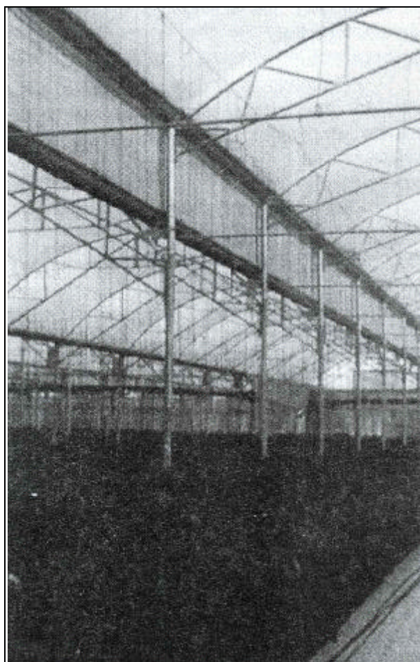
Ventilaciones protegidas con mallas. (Detalle)
