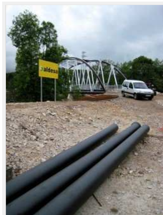
Tubos junto al puente de la Alameda. / T. B.
