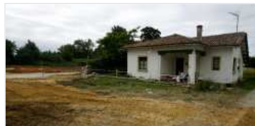
Imagen de ayer por la tarde de una de las viviendas, con la zanja tapada y con la nueva valla en el camino de los Cinamomos. / JOSÉ SIMAL
