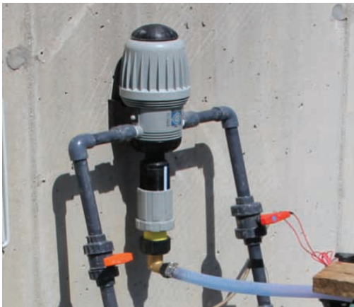
← Inyector hidromecánico.
